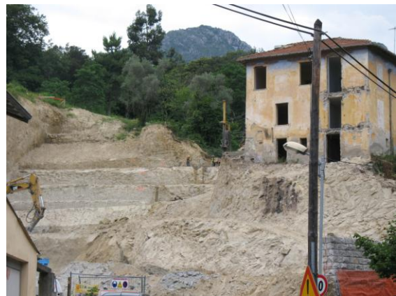
Les travaux sont en cours, la zone est pourtant dite à urbanisation discontinue !
