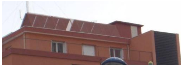
Capteurs solaires sur le toit de la gendarmerie de Menton
